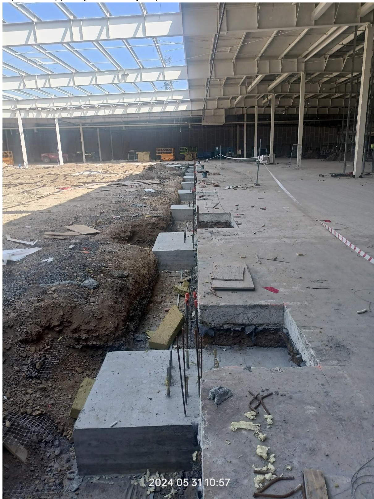
Wykonane stopy w części zasadniczej budynku
