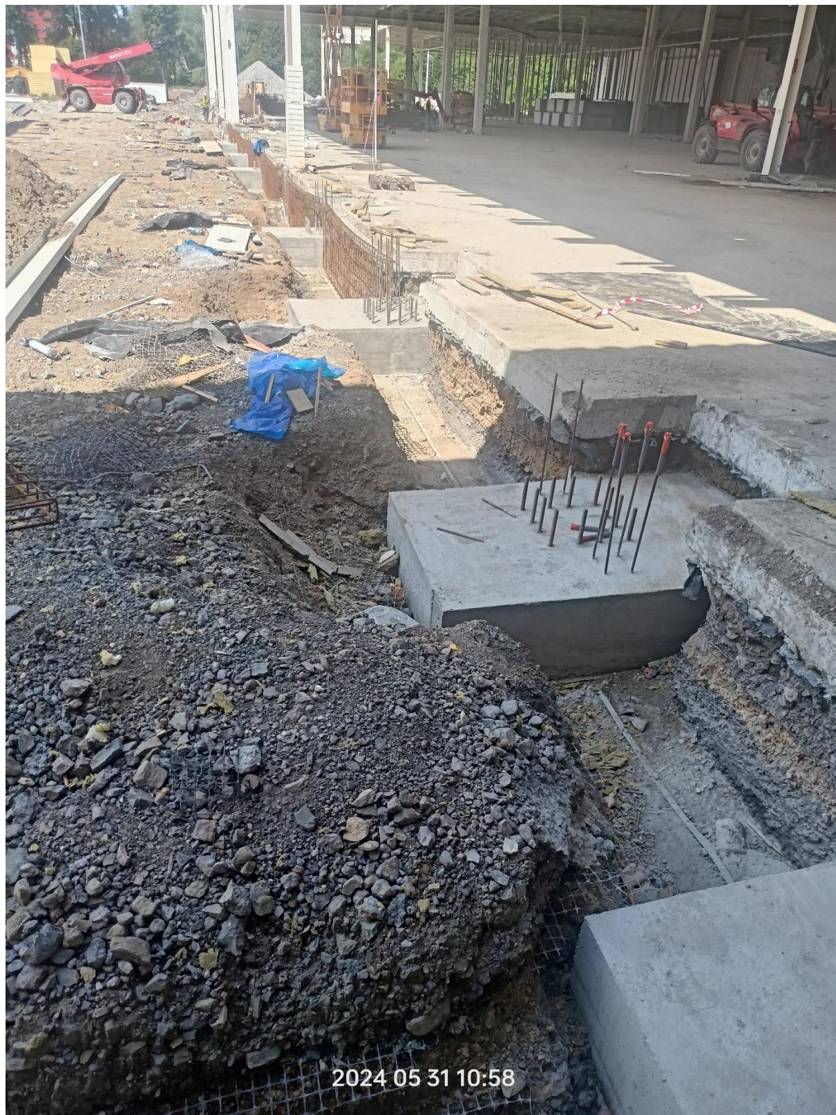
Montaż zbrojenia podwalin
