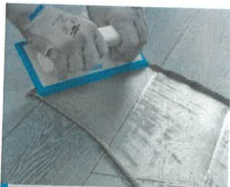
Aplikacja Ultracolor Plus za pomocą pacy gumowej na drewnopodobnej okładzinie z gresu porcelanowego
