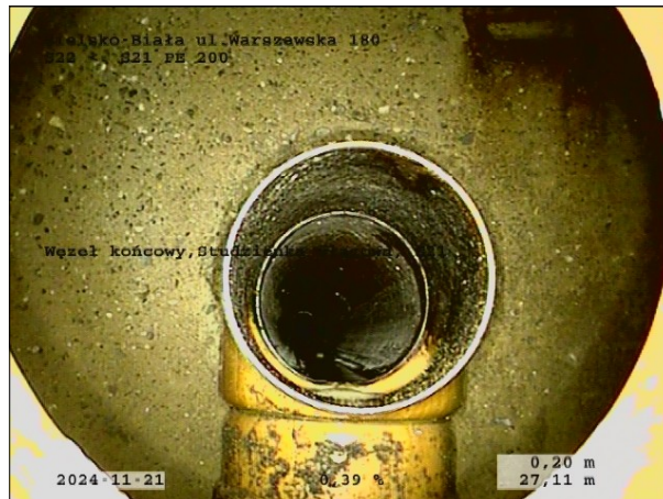
Zdjęcie: 32_2A, 00:02:04 27,11m, Węzeł końcowy, Studzienka włączowa, S21
