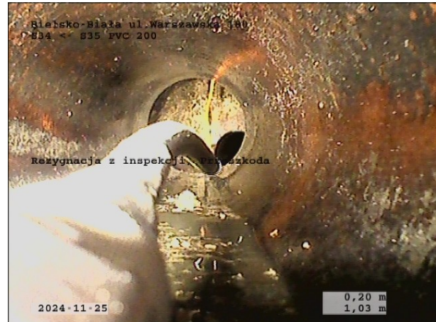
Zdjęcie: 54_2A, 00:01:16 1,03m, Rezygnacja z inspekcji, Przeszkoda
