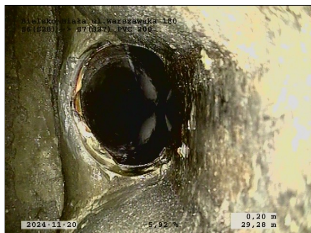
Zdjęcie: 6_2B, 00:02:39 29,19m, Węzeł końcowy, Studzienka włazowa, S7(S27)
