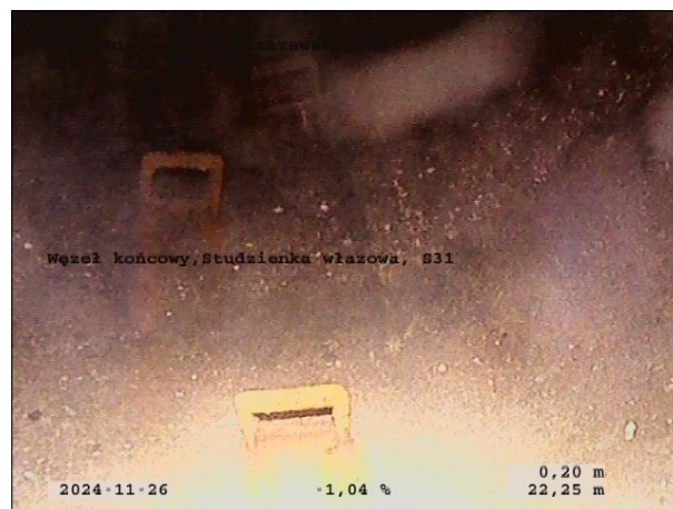
Zdjęcie: 60_2A, 00:02:06 22,25m, Węzeł końcowy, Studzienka włączowa, S31
