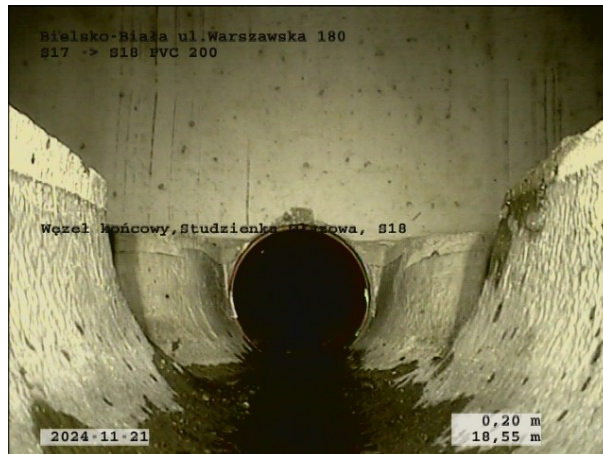
Zdjęcie: 20_2A, 00:01:33 18,55m, Węzeł końcowy, Studzienka włączowa, S18
