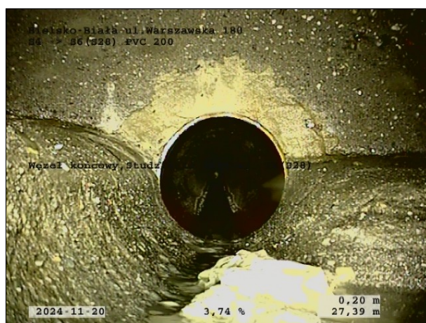
Zdjęcie: 5_3A, 00:03:19 27,39m, Węzeł końcowy, Studzienka włazowa, S6(S28)
