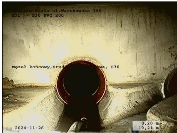
Zdjęcie: 62_2A, 00:01:58 19,21m, Węzeł końcowy, Studzienka włączowa, S30
