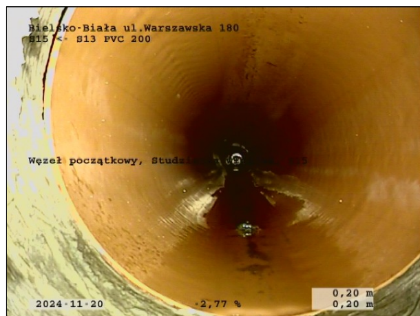
Zdjęcie: 14_1A, 00:00:00 0,2m, Węzeł początkowy, Studzienka włazowa, S15
