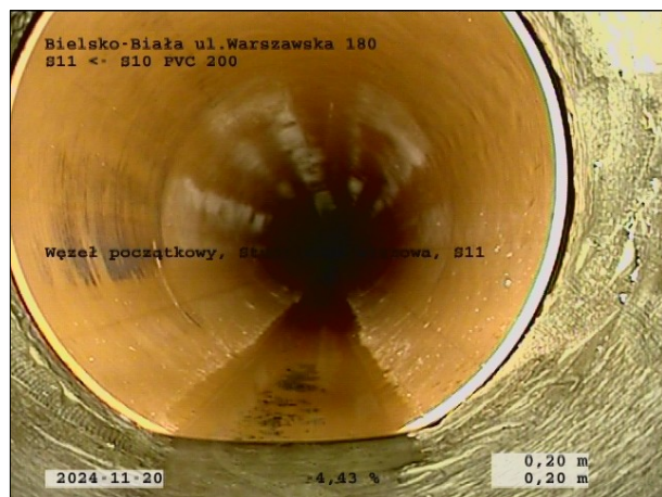
Zdjęcie: 11_1A, 00:00:00 0,2m, Węzeł początkowy, Studzienka włazowa, S11
