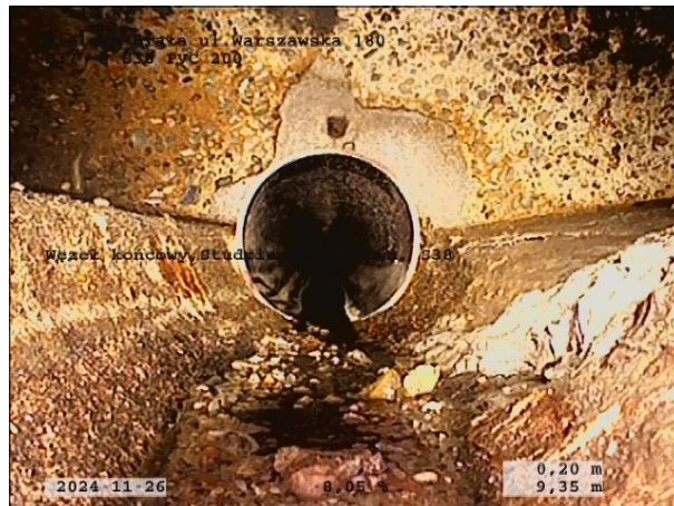
Zdjęcie: 58_2A, 00:01:04 9,35m, Węzeł końcowy, Studzienka włazowa, S38
