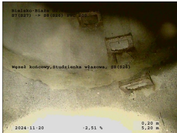
Zdjęcie: 7_2A, 00:01:21 5,2m, Węzeł końcowy, Studzienka włazowa, S8(S26)
