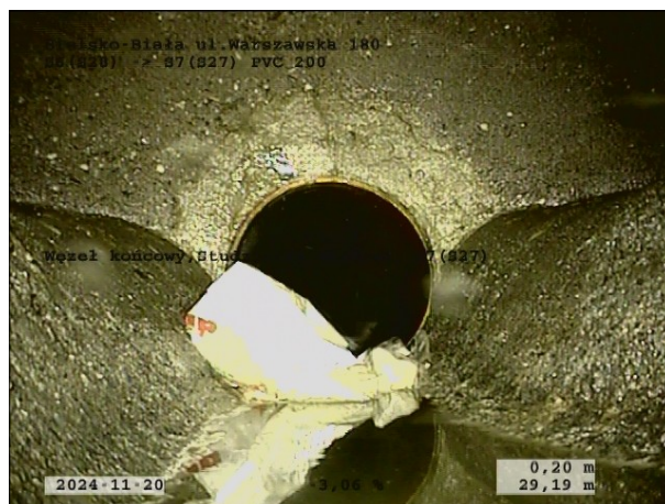
Zdjęcie: 6_2A, 00:02:39 29,19m, Węzeł końcowy, Studzienka włazowa, S7(S27)
