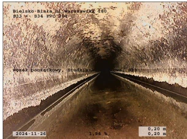
Zdjęcie: 61_1A, 00:00:00 0,2m, Węzeł początkowy, Studzienka włazowa, S33
