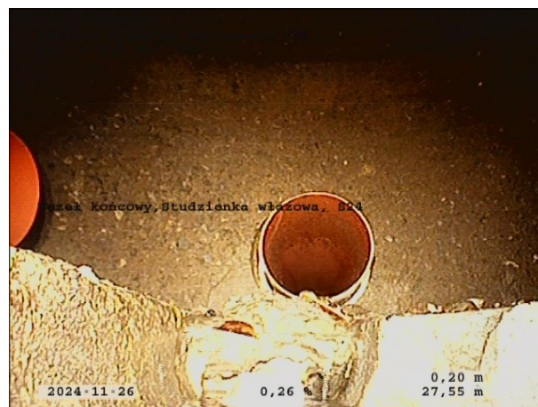
Zdjęcie: 63_2A, 00:04:16 27,55m, Węzeł końcowy, Studzienka włączowa, S24
