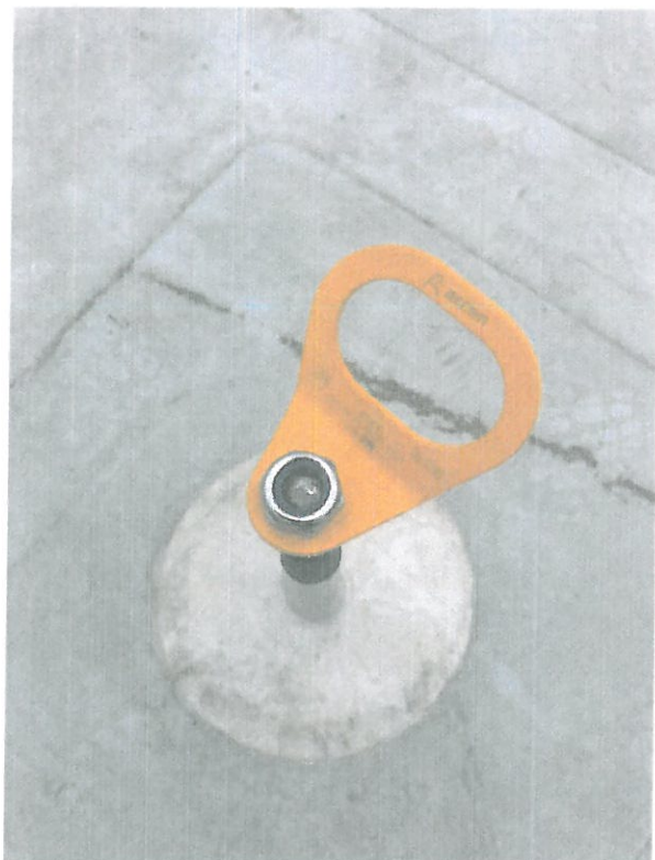
● Zdjęcie 68 – Dokręcić wszystkie nakrętki w systemie asekuracji. Dostarczyć protokół odbioru montażu przez producenta.
