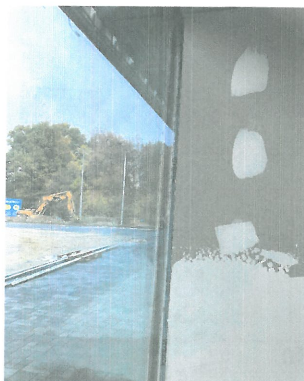
● Zdjęcie 24 – Prześwit pomiędzy witryną a czołem ściany międzylokalowej. Dotyczy wszystkich ścian międzylokalowych
