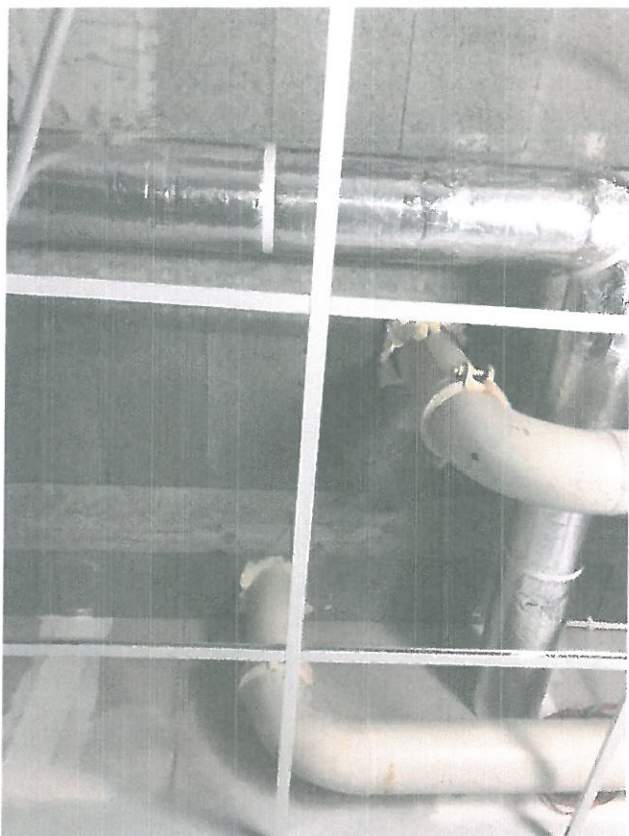
● Zdjęcie 25 – Przed zakryciem sufitów, wykonać przejścia ppoż., lokalizacja – pom. techniczne
