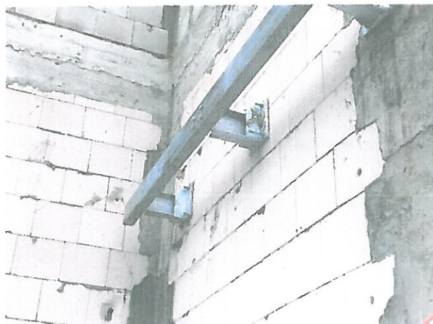
Zdjęcie 40 – montaż bezpośrednio do ściany murowanej powinien być z użyciem kotwy chemicznej
