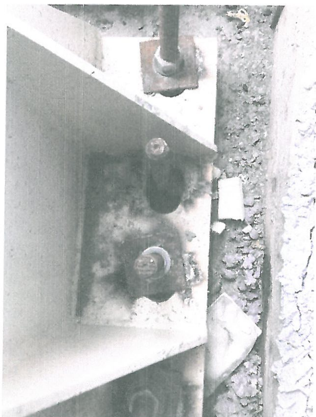
Foto 6 – możliwość powiększenia otworów w blachach podstaw słupów należy uzgodnić z projektantem.
