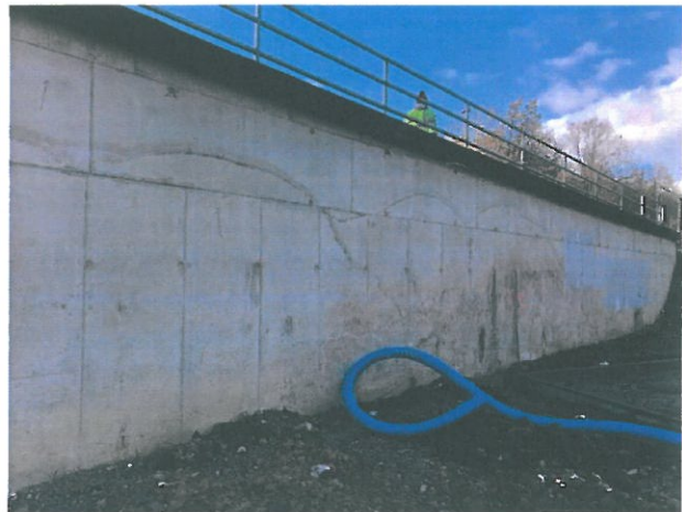
● Zdjęcie 57, Oczyszczyć mur oporowy od str. Ul. Warszawskiej po składowaniu materiału
