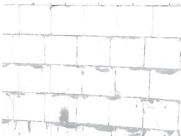
Foto 10 – nieprawidłowe przewiązanie murarskie, oś K'
