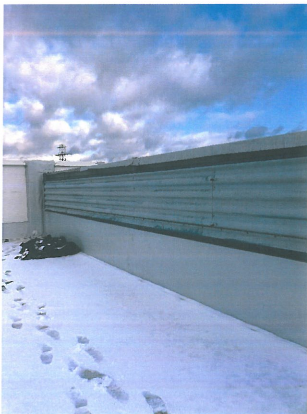
● Zdjęcie 11, Dokończyć obróbki attyk na styku dachu niskiego z wyższym
