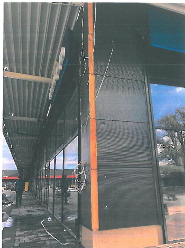
Zdjęcie 28, Wykonać brakujące obróbki ścian osłonowych WYKONANO
