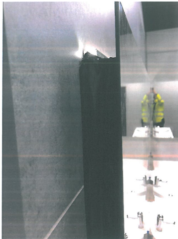
• Zdjęcie 42, Wykonać maskownicę za lustrami. Aktualnie zaklejone nieestetycznie taśmą
