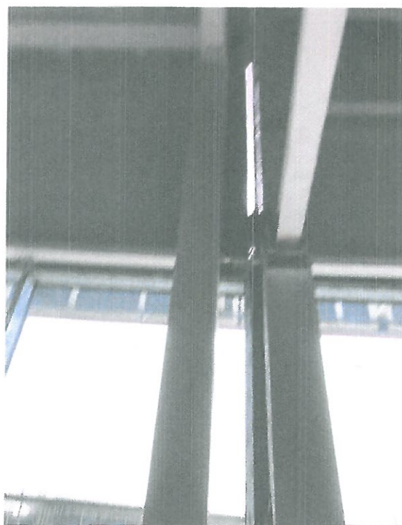
● Zdjęcie 93 – Brak wykończenia i izolacji ściany zewn. przy dylatacji konstrukcyjnej. Oś 11.
