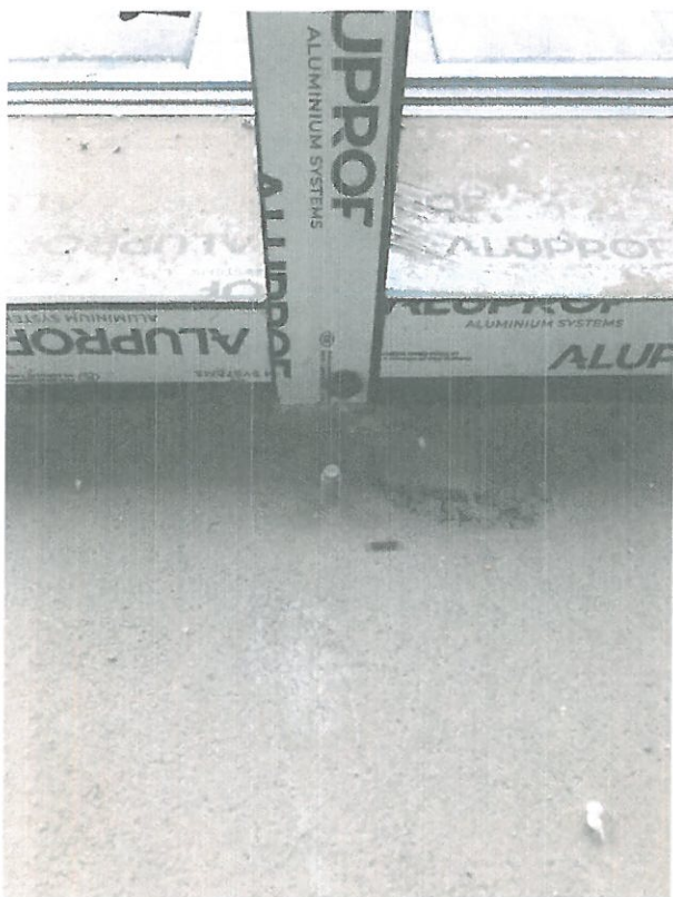
● Zdjęcie 25 – Usunąć wystający element z posadzki. Lokal L01
