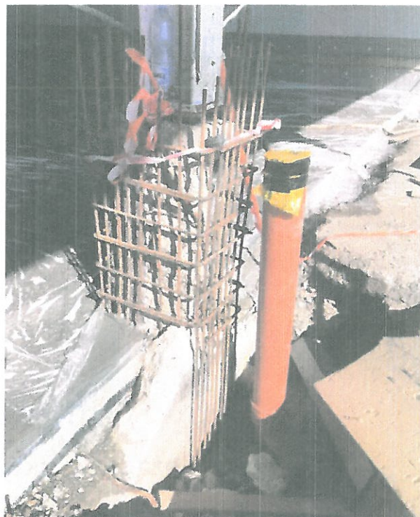
Zdjęcie 2 – Wykonanie niezgodne z projektem – wyjaśnić z projektantem (rysunek stopy ST-14)
