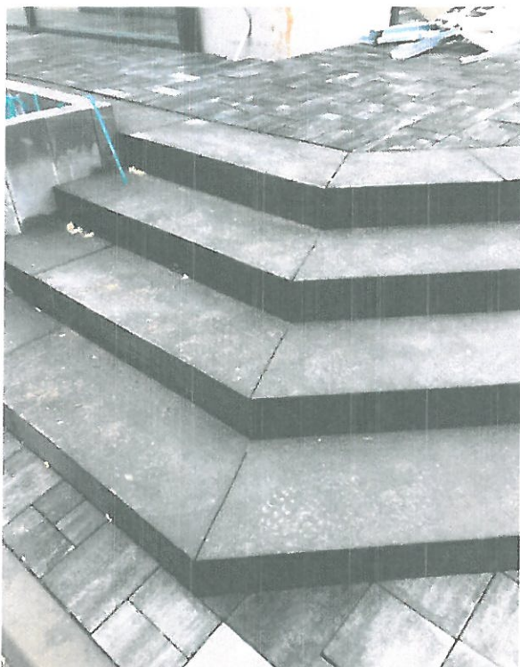
● Zdjęcie 105 – Niestarannie docięte stopnie schodów terenowych – nierówne, wyszczerbione krawędzie
