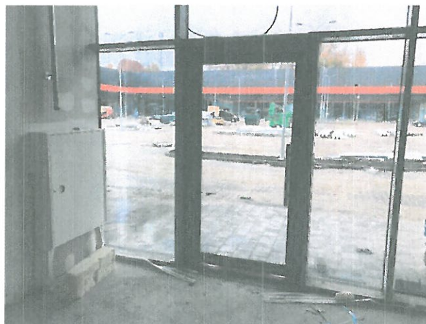
● Zdjęcie 12 – Podłączyć hydrant do instalacji w lokalu L.05d
