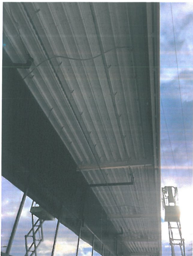
Zdjęcie 27, Montaż podsufitki zadaszenia wymaga natychmiastowego zwiększenia tempa i ilości ludzi!
