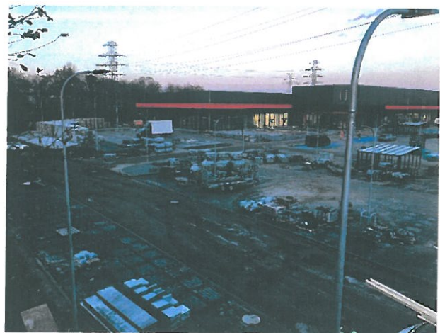
Zdjęcie 69, Posprzątać teren inwestycji, usunąć materiał przeznaczony dla budowy sąsiedniego obiektu KOMFORT
