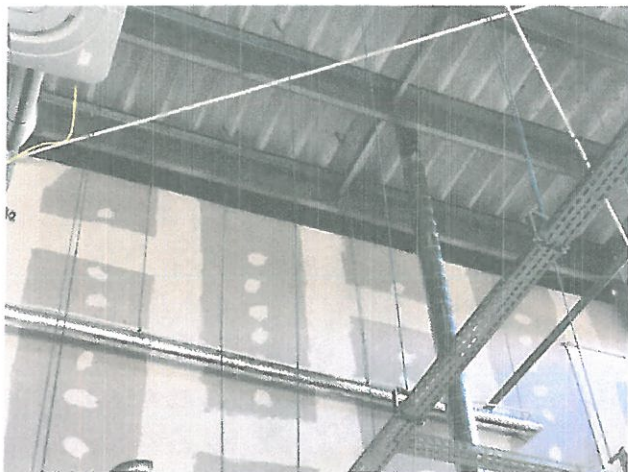
● Zdjęcie 5 – Nieukończona ściana międzylokalowa – pusta przestrzeń pod dachem, Etap 2
