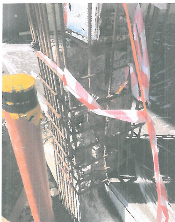
Zdjęcie 3 – Wykonanie niezgodne z projektem – wyjaśnić z projektantem (rysunek stopy ST-14)
