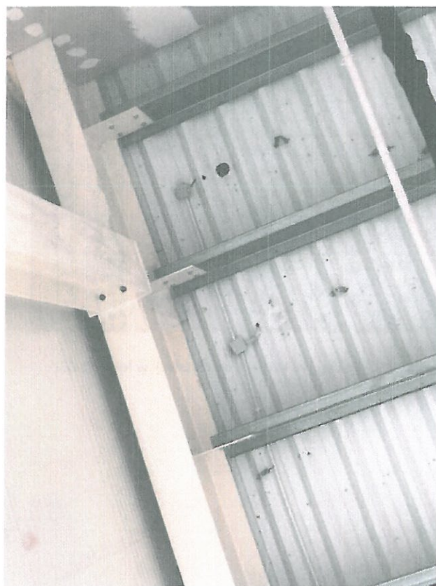
● Zdjęcie 18 – Usunąć pozostałości starych instalacji z dachu
