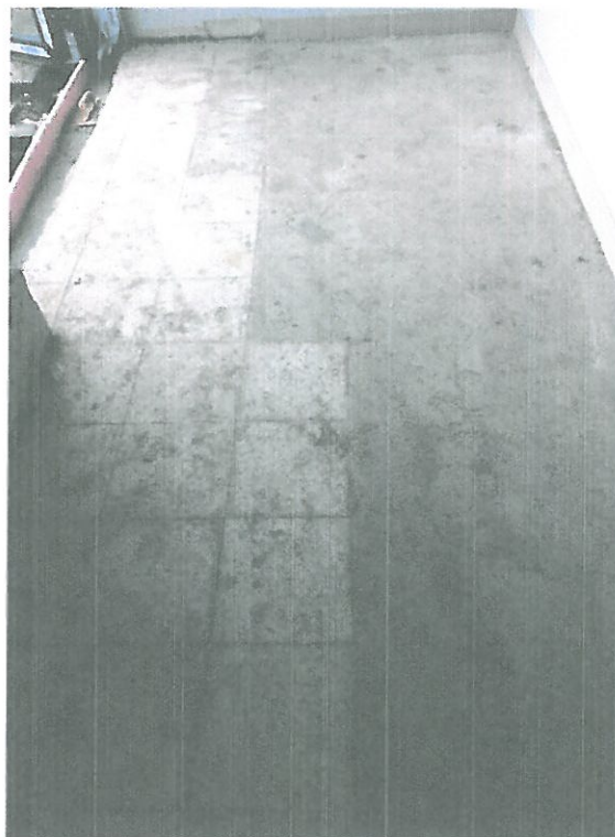
Zdjęcie 2 – Wykonać posadzkę w korytarzu do lokalu L09a zgodnie z Umową – lastryko
