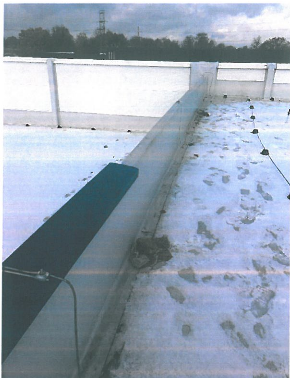
● Zdjęcie 9, Dokończyć montaż obróbek attyk, dotyczy całego dachu
