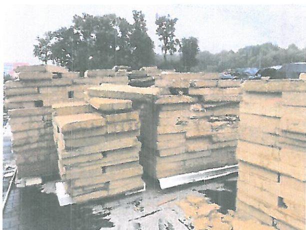
● Zdjęcie 22 – Wełna niezabezpieczona przed opadami. W przypadku stwierdzenia zbyt dużej wilgotności, wełna będzie do wymiany. Zastrzegam możliwość żądania odkrywek.
