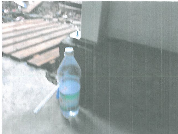
Zdjęcie 10 – Brak podlewki pod słupkiem ryglówki, przykład z KAUFLAND
