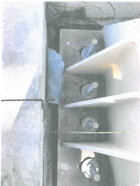
Zdjęcie 11 – (1) nieprawidłowe blachy (podkładki) pod nakrętkami – niezgodne z projektem, za małe, za cienkie. (2) Możliwość powiększania otworów uzgodnić z projektantem (wysłano RFI)
