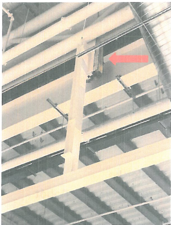
● Zdjęcie 1 – Usunąć pozostałości po rozbiórkach (tutaj fragment płyty warstwowej) – lokalizacja KAUF LAND
